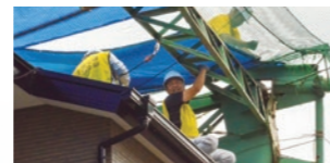
千葉台風被害で倒壊したゴルフ場の柱につぶされた屋根の応急処置
