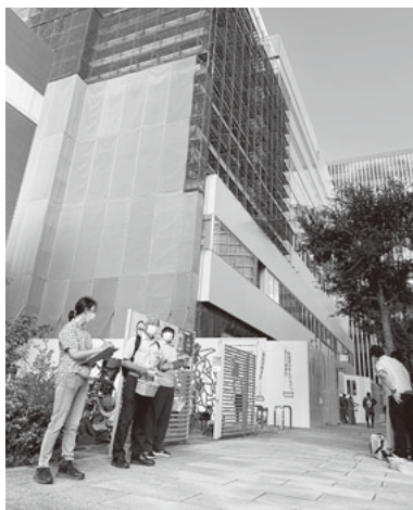
神奈川大学校舎新築工事早期 宣伝を行う仲間たち
