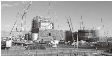
横須賀火力発電所除却工事現場
