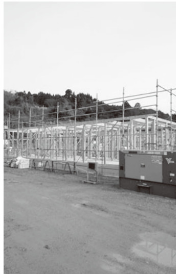
建て方工事を終えた仮設住宅
