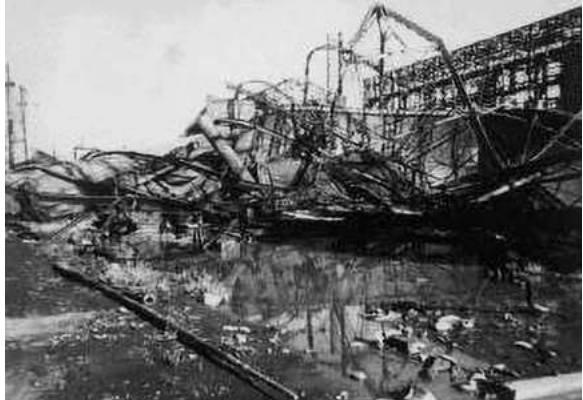
【下】破壊された工場
